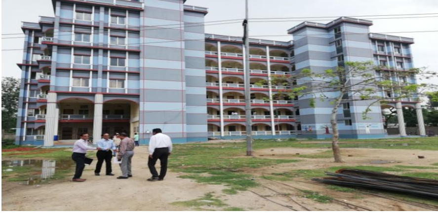
ছবি : নির্মিত একাডেমিক ভবন এবং শ্রেণিকক্ষ
